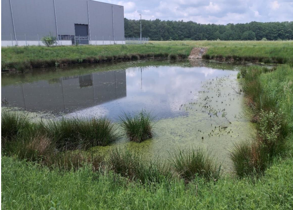
Abbildung 42: Regenrückhaltebecken innerhalb des Geltungsbereichs. Foto: Mai 2024, Stutzmann
