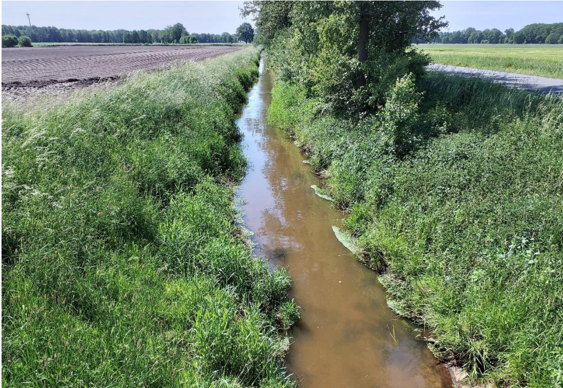
Abbildung 63: Blick auf die Steinbäke im nördlichen Untersuchungsgebiet. Foto: Mai 2024, Stutzmann.
